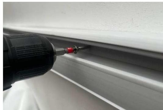
Forare la base con delle viti per fissarla all'imbarcazione.
